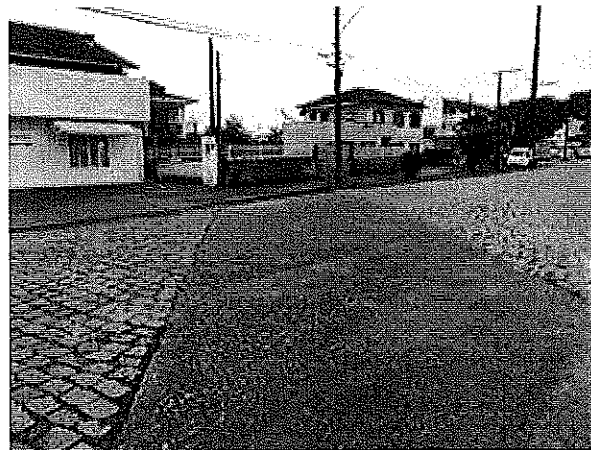
Figura 3 – Vista da Rua Dom Bosco - Descarga
