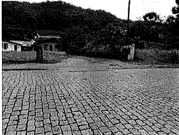
Figura 4 – Vista da Rua Piratuba – Travessia do Rio Mirandinha
