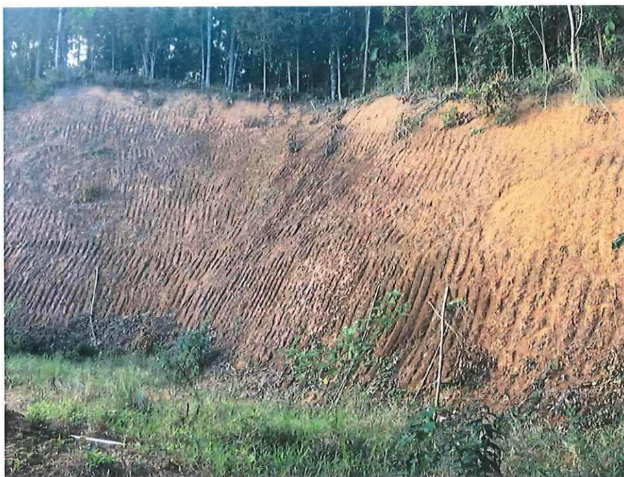
Foto 2.6 - Vista central do talude.
