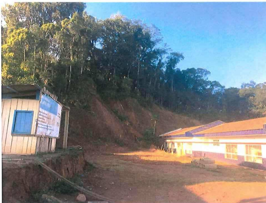
Foto 2.1 - Talude nos fundos da edificação.
