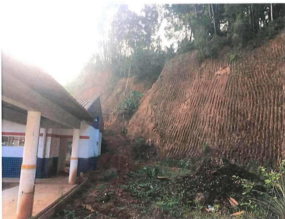
Foto 2.4 - Vista lado leste do talude.
