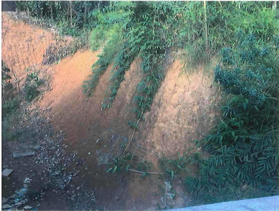
Foto 2.7 - Vista lado oeste do talude.
