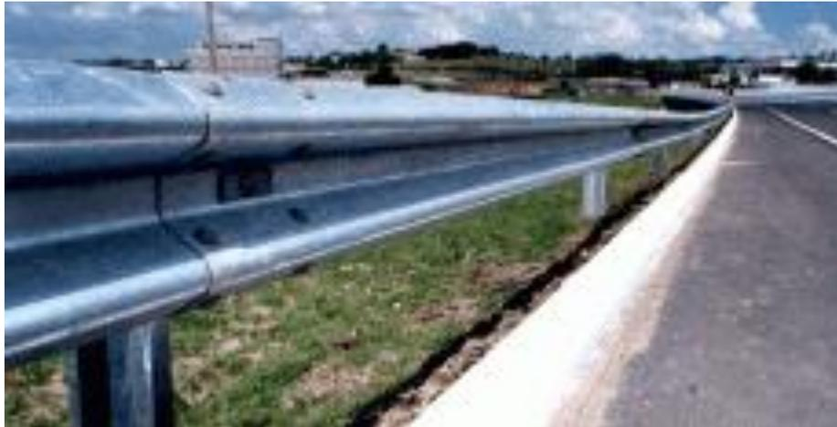
**Figura 4.14 - Defesa metálica.**
