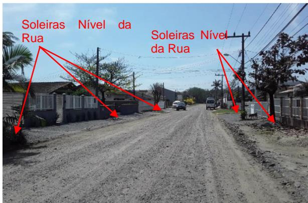
**Figura 1.1 - Rua Alex Kricheldorf– Segmento com identificação das soleiras dos portões em relação ao nível da pista existente.**
