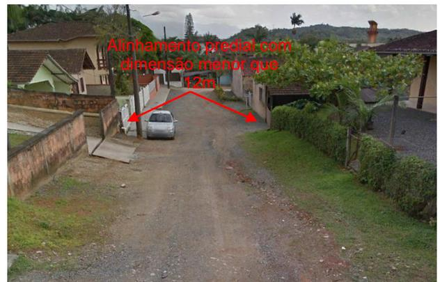
**Figura 1.2 - Rua Orestes Girardi - Trecho com alinhamento predial existente, impactando na largura da via projetada.**
