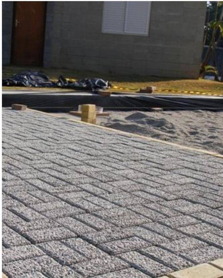
**Figura 4.1 - Bloco de concreto retangular drenante.**
