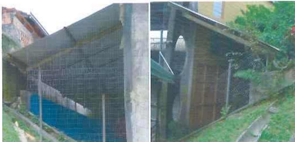
Fotos da cobertura a ser retirada da arquivancada.
