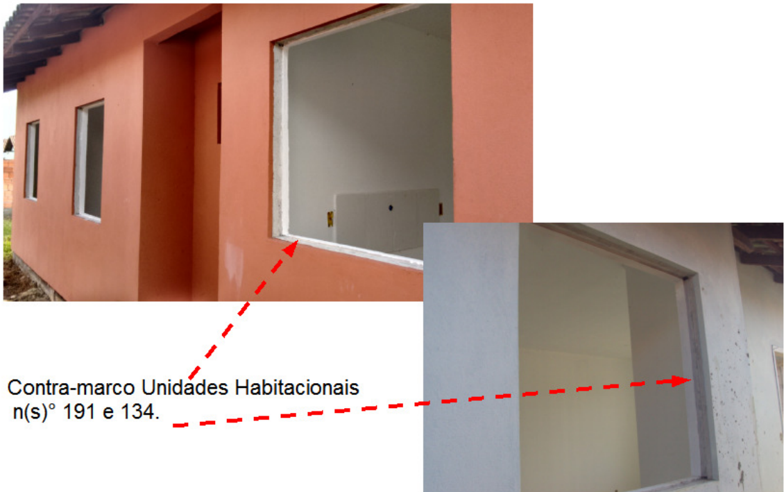
Imagem 9 – Existência de contra-marco em alumínio.
