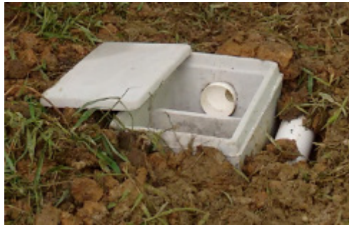
Imagem 7 – Caixa de gordura pré-fabricada com divisor móvel.
