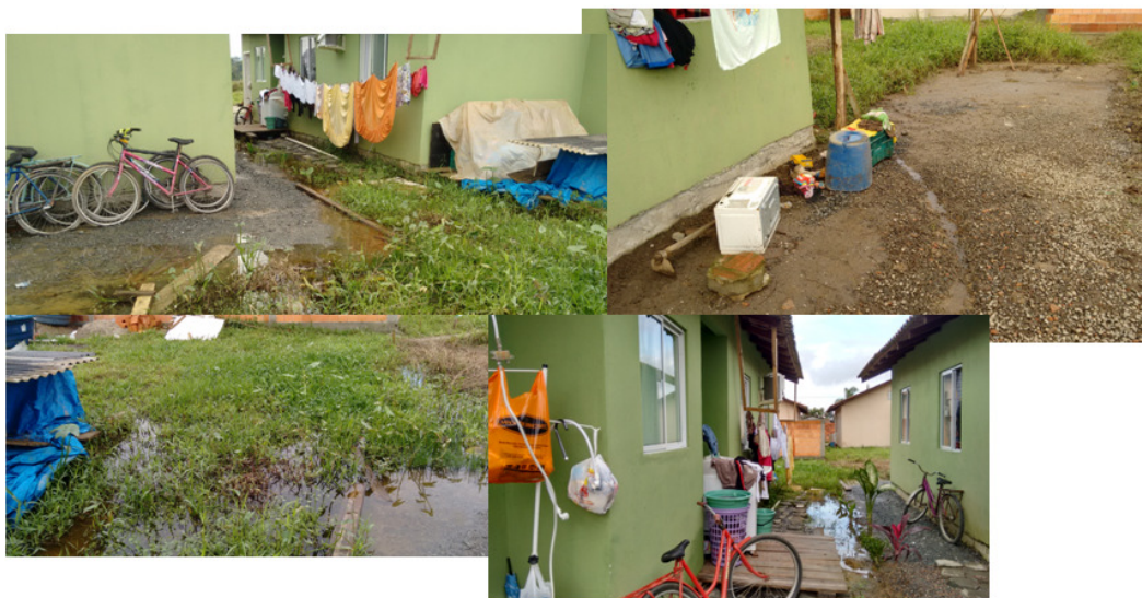
Imagem 15 – Águas pluviais estagnadas no fundo dos lotes.
