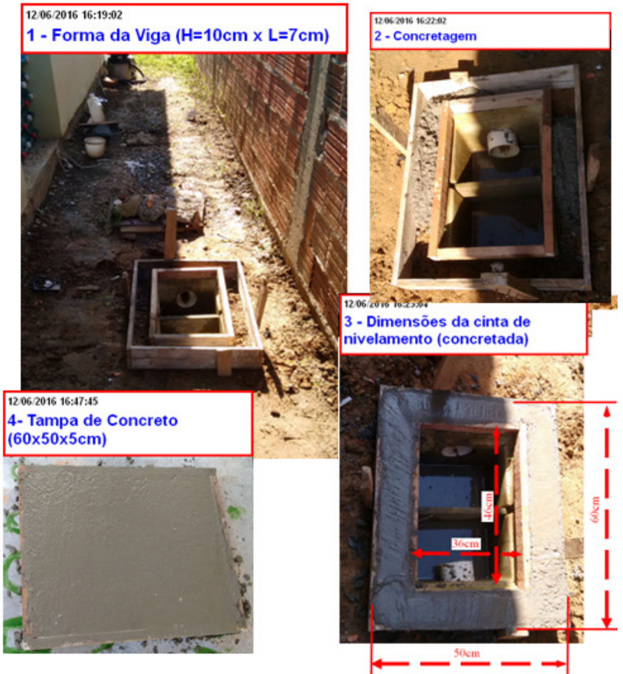
Imagem 6 – Apresenta a seqüência da execução da viga de nivelamento e da tampa das caixas de gordura e inspeção existentes.
