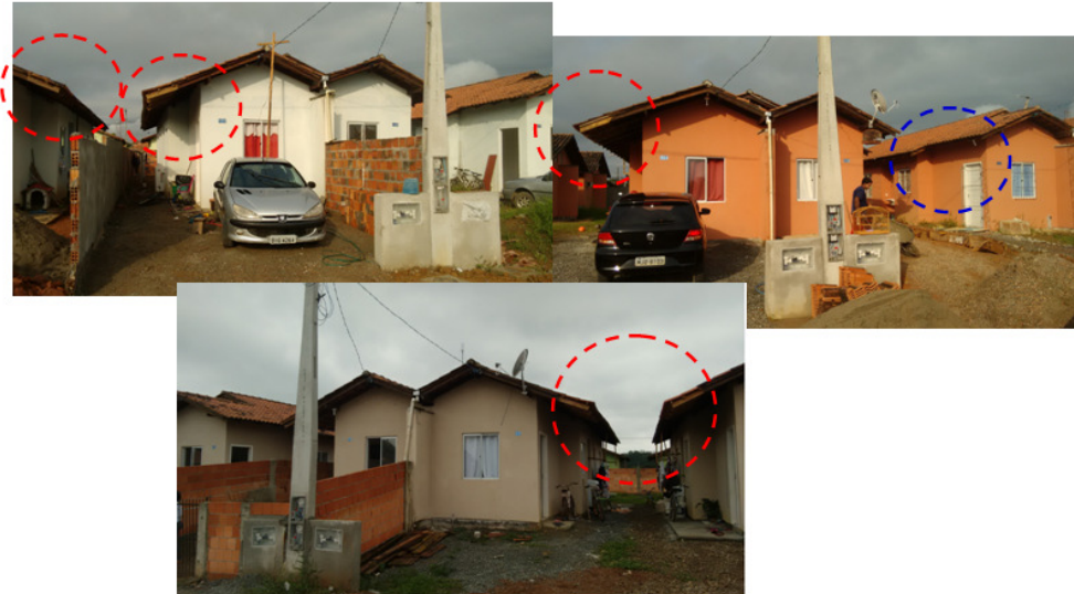
Imagem 18 – Prolongamento dos beirais realizados pelos beneficiários (círculo vermelho), e projeto original (círculo azul).
