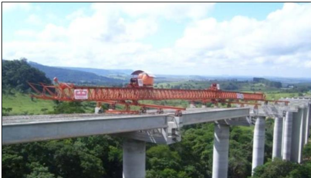
Figura 4 - DETALHE TRELIÇA LANÇADEIRA
