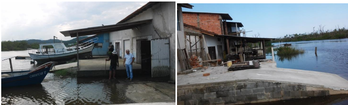
Foto 2 e 3 – Vista Externa da construção pelo lado do canal.
