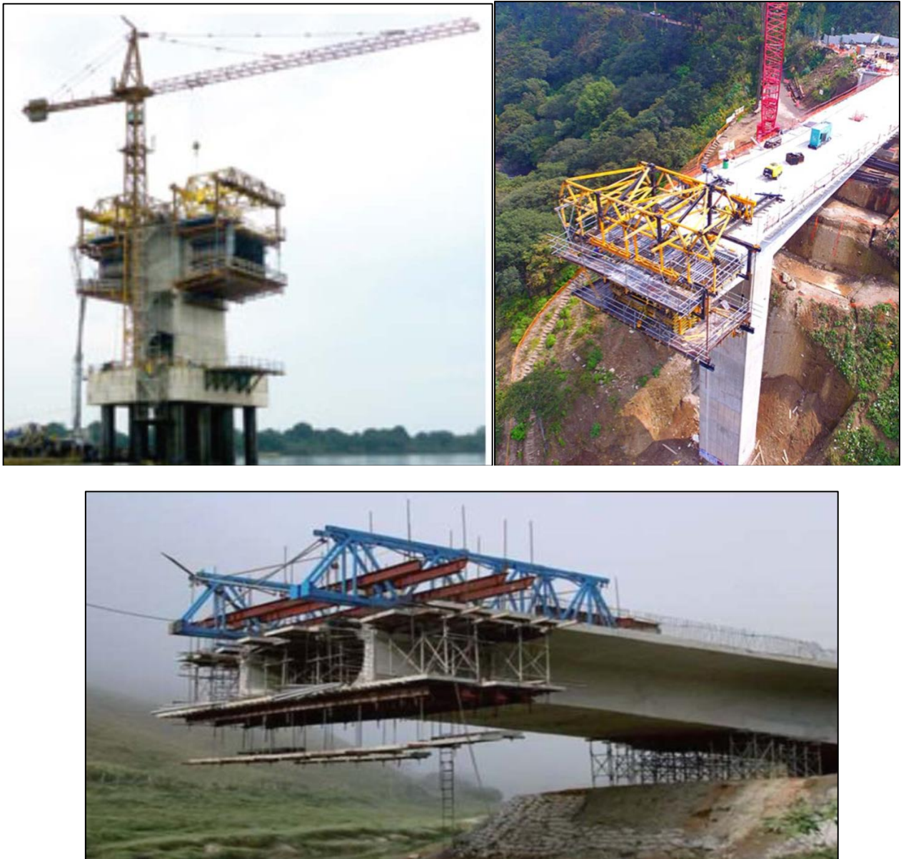
Figura 6 - FOTO EXECUÇÃO DE BALANÇO SUCESSIVO
