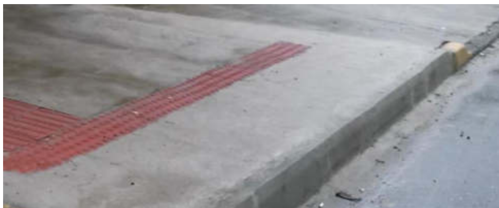
Foto 1 – Padrão de Implantação de piso tátil das calçadas em Joinville - Visita a Joinville em 31/07/2017 – Planave S/A
