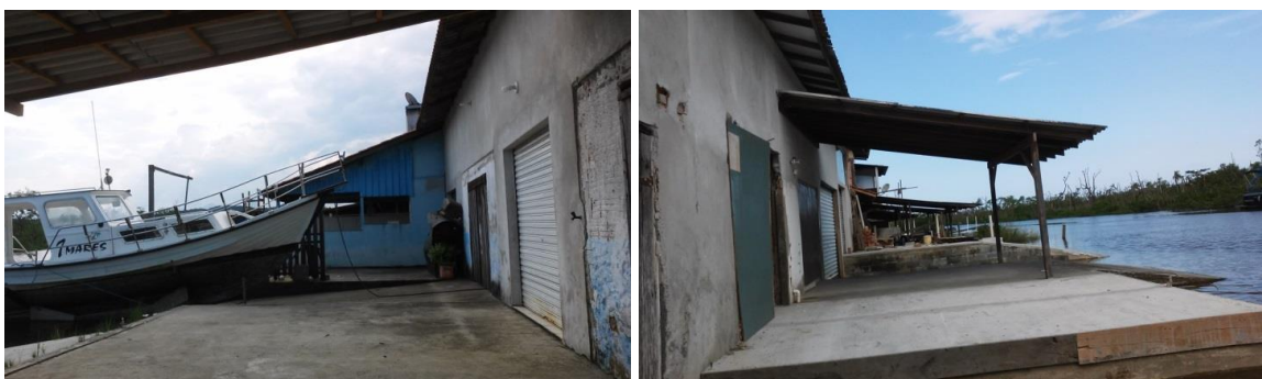
Foto 4 e 5 – Vista Externa da construção pelo lado do canal.
