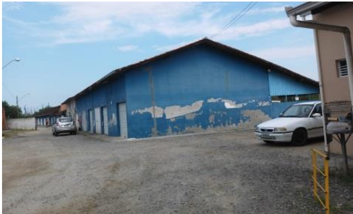
Foto 1 – Vista Externa da construção.
