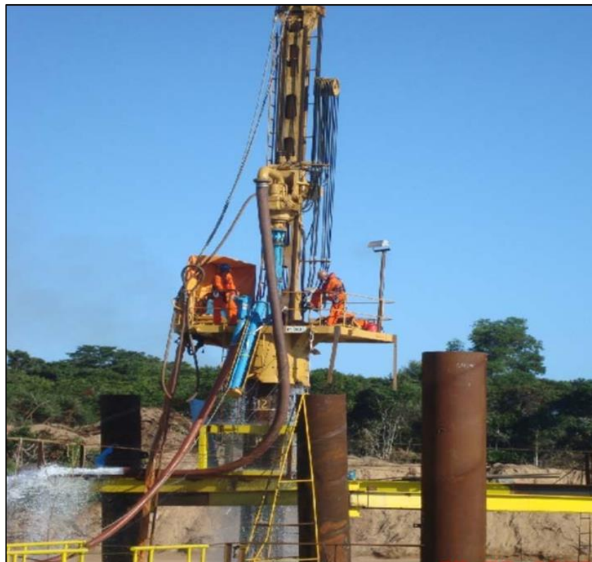
Figura 12 - DETALHE CRAVAÇÃO DA CAMISA
