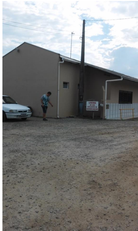
Foto 6 – Vista Externa da construção da Associação dos Pescadores.
