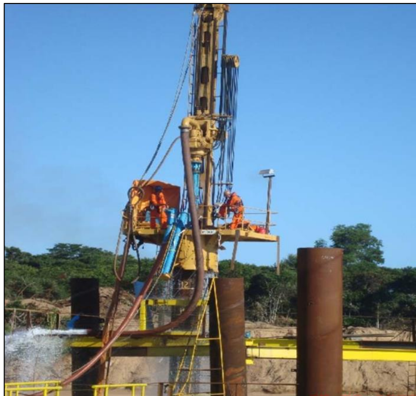
Figura 12 - DETALHE CRAVAÇÃO DA CAMISA
