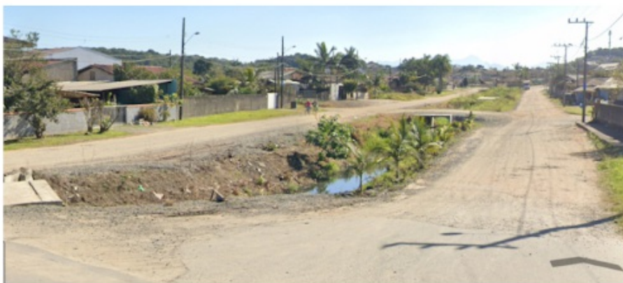
Imagem atual do local da obra. Fonte: Google Maps (2021).
