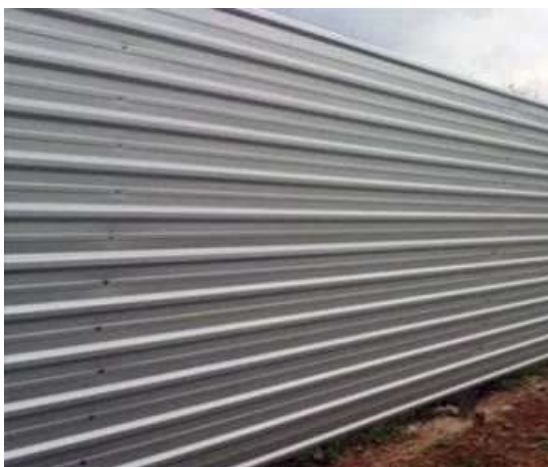
TAPUME EM TELHA METÁLICA
