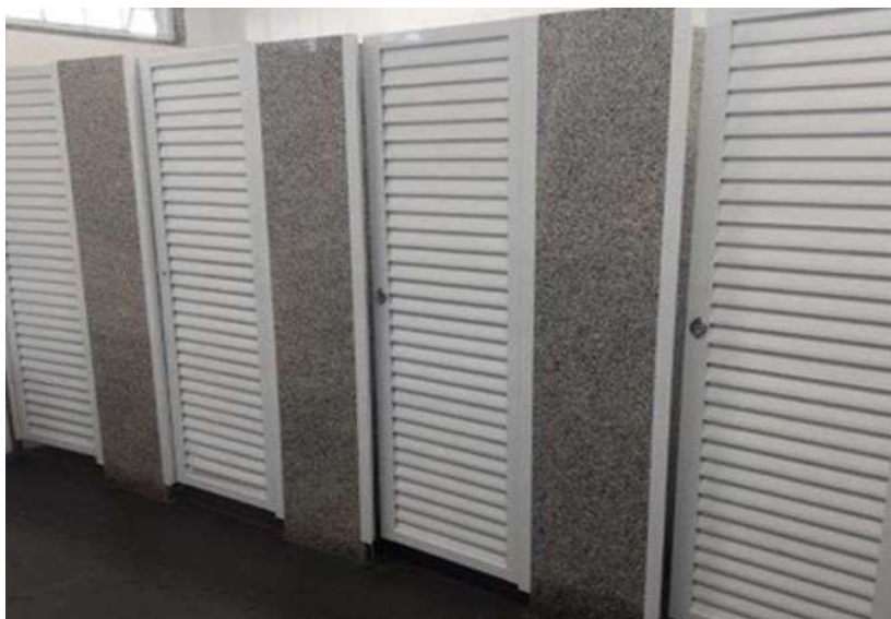
DIVISÓRIAS SANITÁRIAS DIVISÓRIA DE GRANITO CINZA ANDORINHA PORTAS COM VENEZIANA VENTILADA
