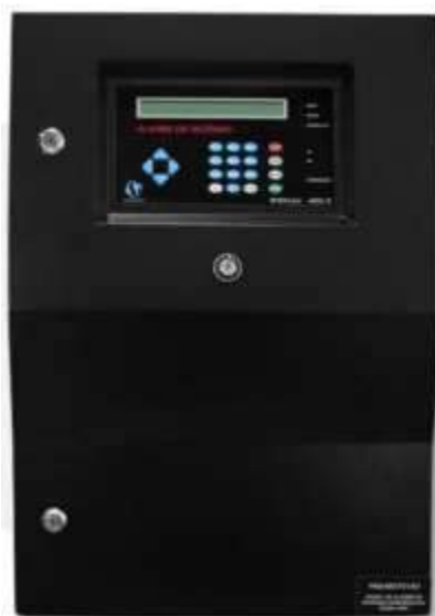
CENTRAL DE ALARME DE INCÊNDIO ANALÓGICA
