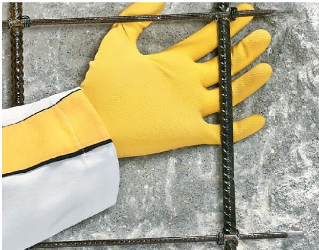
3° - Limpar a ferrugem com uma escova de aço. Aplicar sobre toda a armadura, com pincel, uma camada de um produto inibidor de corrosão e aguardar secar;
