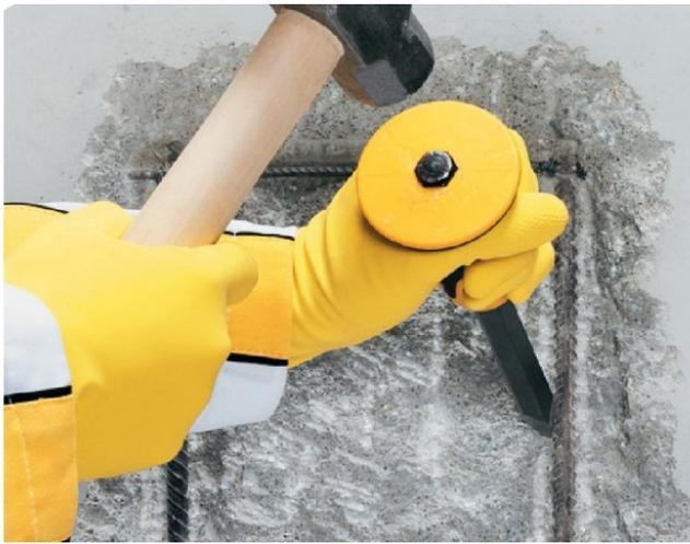
2° - Retirar o concreto em volta das armaduras corroídas, deixando, no mínimo, 2 cm livres em seu contorno;
