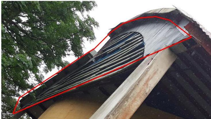
Foto do oitão a ser demolido e substituído por novos materiais
