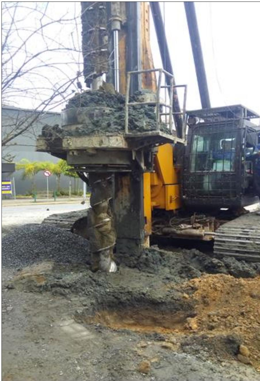
Foto 1 - Perfuração do Poço 1 com trado mecânico.
